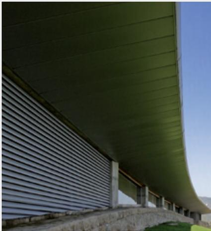
El panel Sandwich Wall es un producto arquitectónico con características aislantes, fabricado en 50 y 35 mm de espesor y en anchos estándares de 300 / 470 / 500 / 565 / 600 mm con un largo máximo de 9,8 m. Compuesto por dos planchas metálicas de aluzinc en espesor 0,6 mm, separadas entre si por poliuretano inyectado de densidad 60 kg/m<sup>3</sup>.
